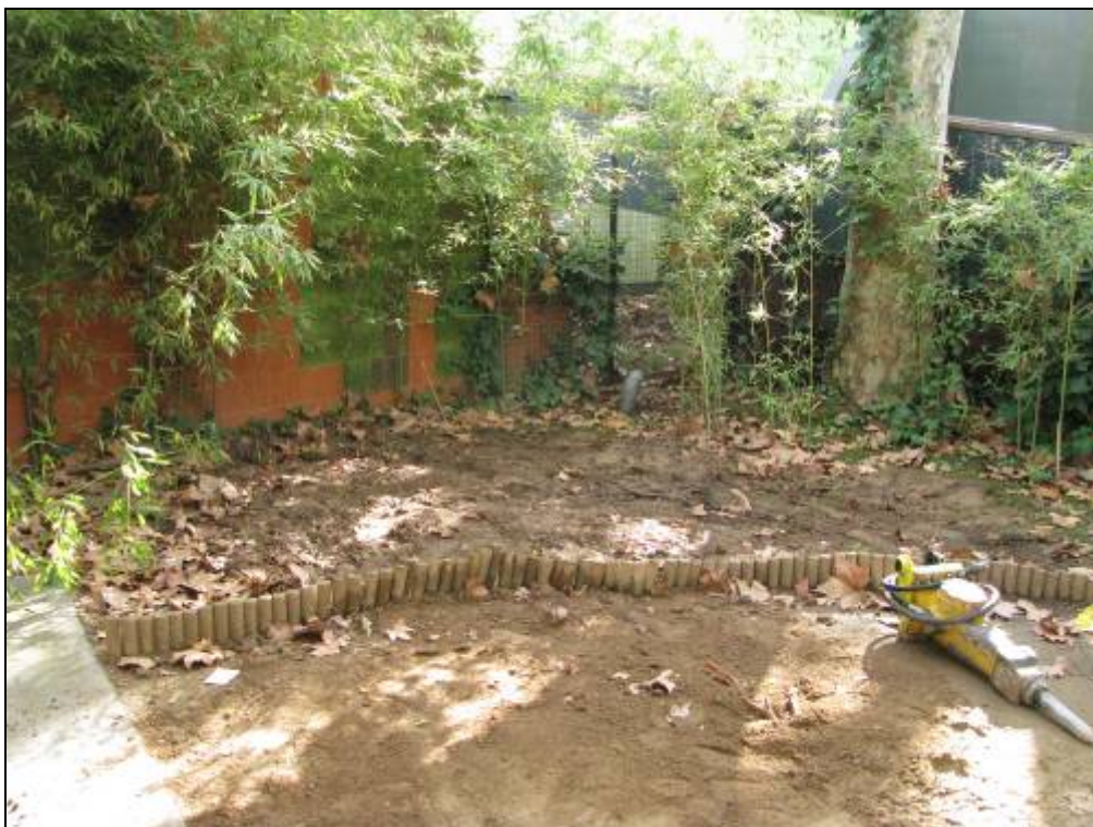
Espai on s'obrí la rasa 1 un cop reblerta.
