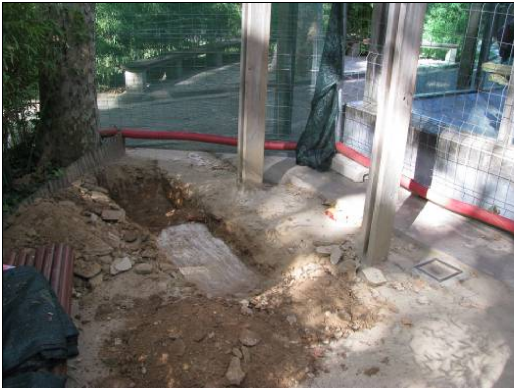
Forjat de formigó UE 1001 a la rasa 2.
