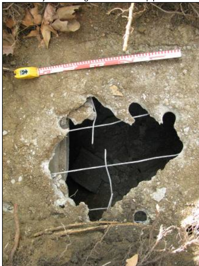
Detalla del forjat del formigó.
