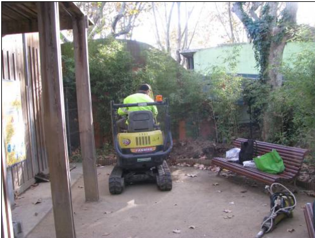
Obertura de la rasa 1.
