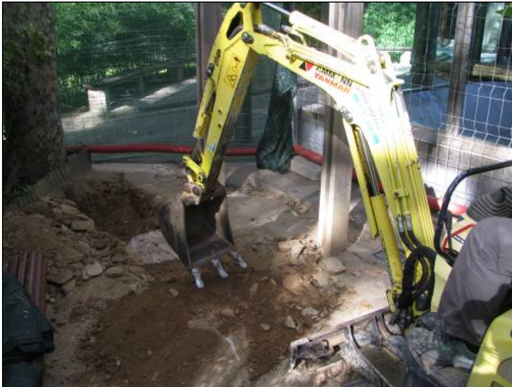
Obertura de la rasa 2.
