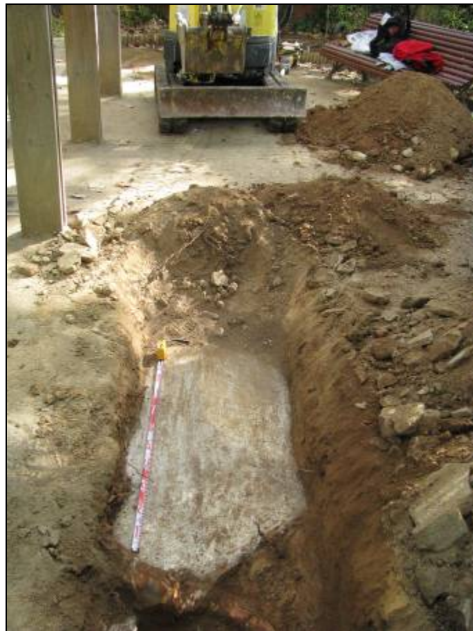
Forjat de formigó UE 1001 a la rasa 2.
