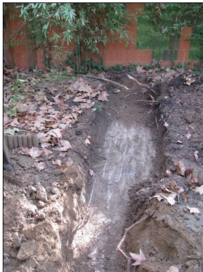
Forjat de formigó UE 1001 a la rasa 1.
